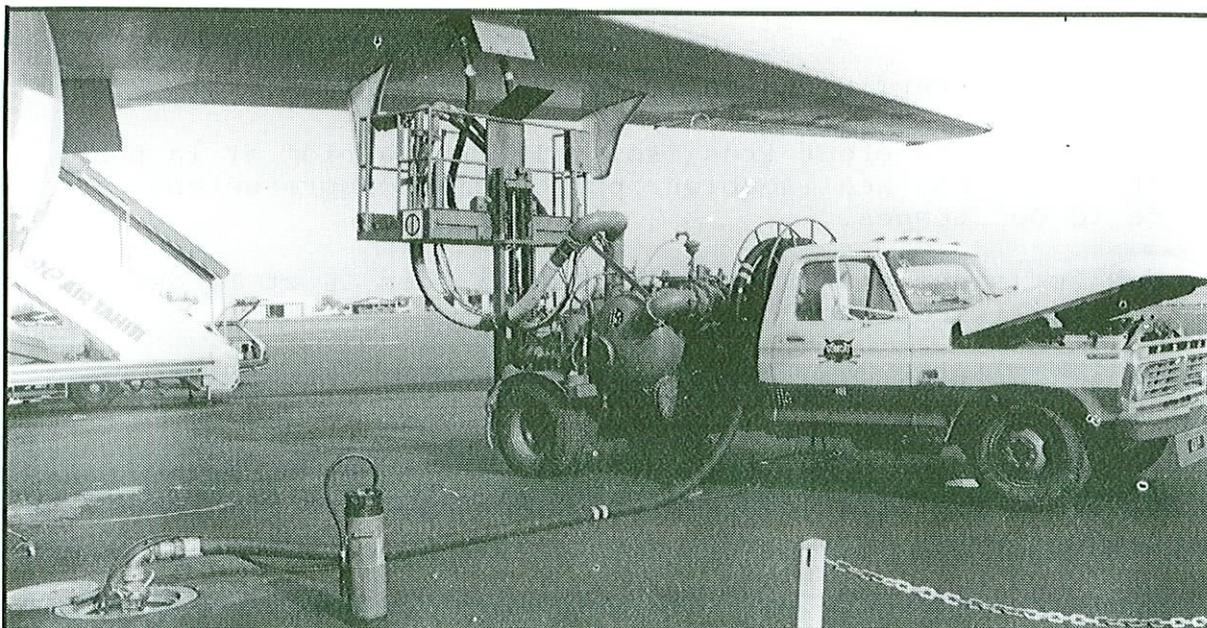
Pour éviter que les camions citernes traversent la piste pour se rendre dans la zone nord de l'aérodrome où sont installées les cuves ; il a été décidé d'implanter une station de dépotage en zone sud avec un système (pompe - canalisation enterrée) pour le transfert du carburant puis le remplissage des cuves.
