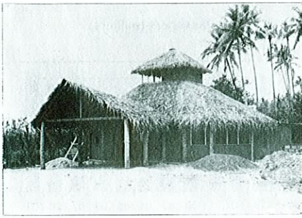
A la suite de la destruction de l'abri passagers initial, une nouvelle construction rudimentaire fut réalisée avec du bois et du "niau". Au sommet, depuis la vigie, le contrôleur assurait la bonne marche des opérations aériennes.
