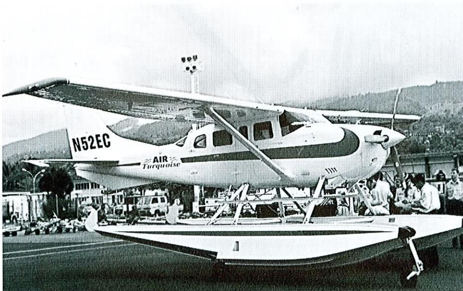
Le Cessna 206 amphibie, à la différence d'un simple hydravion, dispose, sous les flotteurs, de roues lui permettant de se poser sur une piste.
